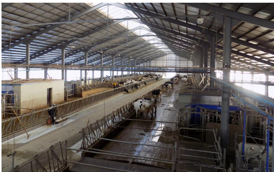
Рис. 1. Загальний вид ферми на 400 корів з утриманням тварин у боксах. Ліворуч та праворуч від кормового столу два спарені модулі роботизованої доїльної системи.
