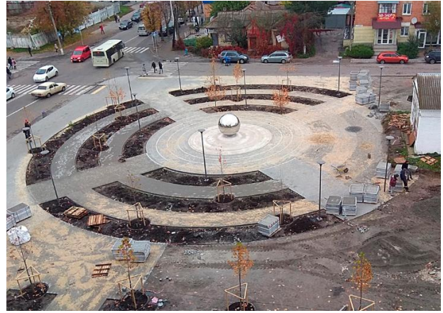
Рис. 10. Загальний вигляд площі в процесі виконання робіт.
