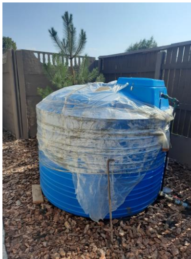
Рис. 2. Резервуар води для зрошення.
